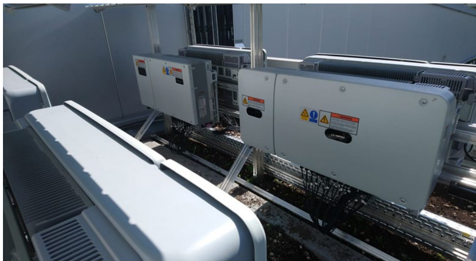
Wechselrichter inkl. Wechselrichtergestell
