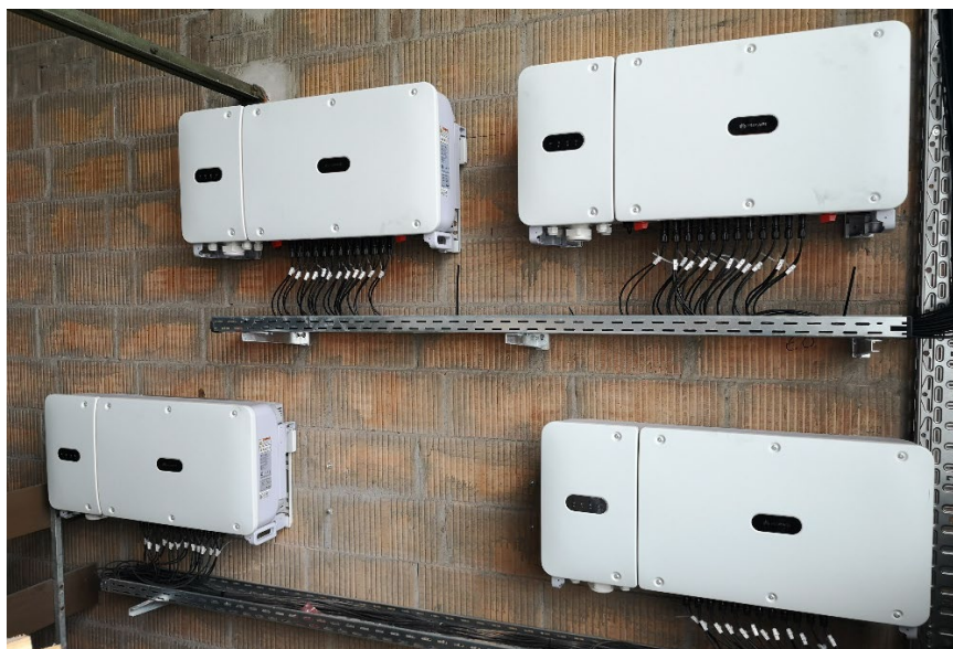
Wechselrichter 1 - 4
