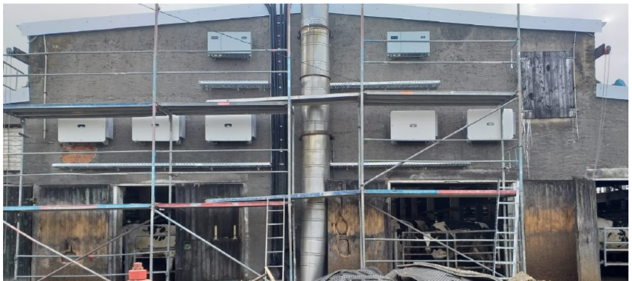
Wechselrichter
