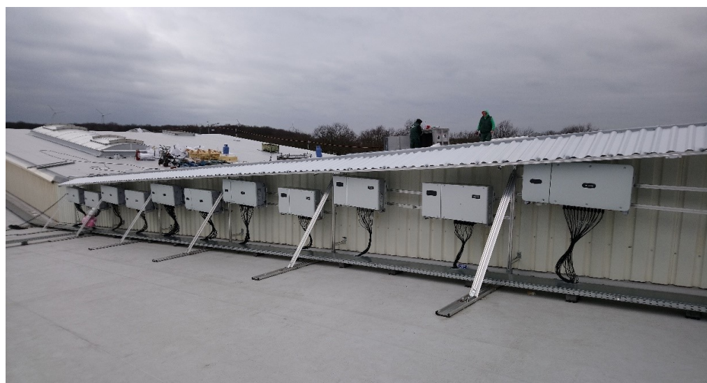
Wechselrichter inkl. Kabelkanal
