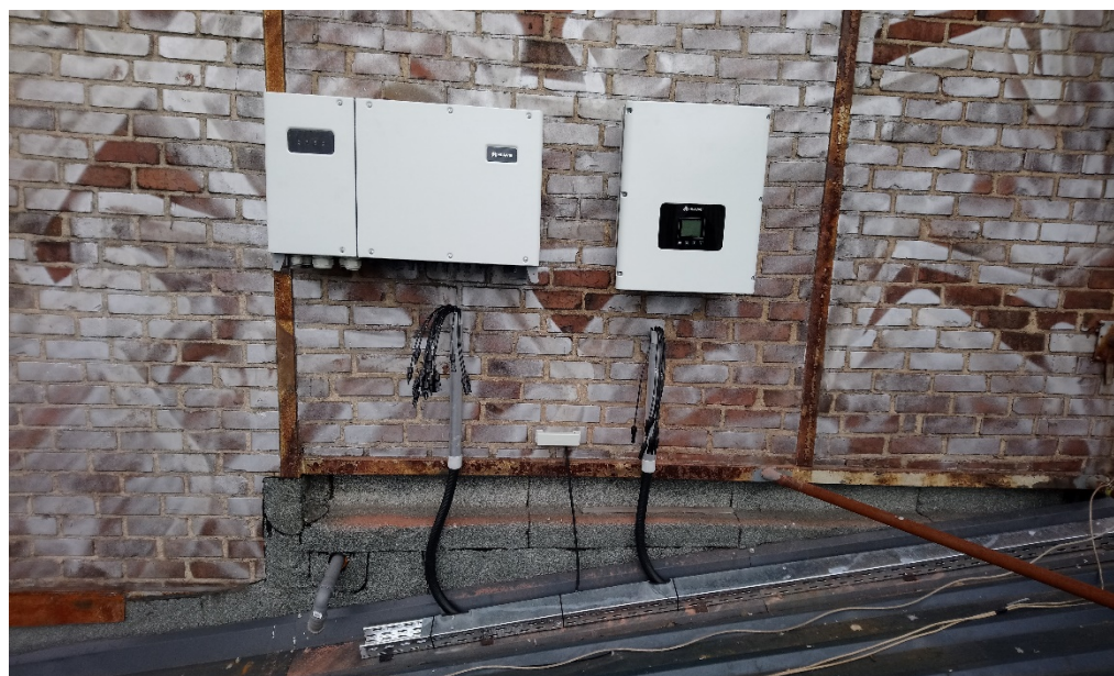
Wechselrichter inkl. Kabelkanal
