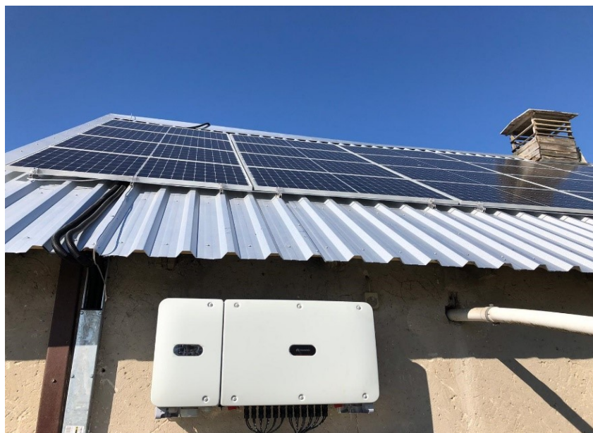
Wechselrichter inkl. Kabelkanal
