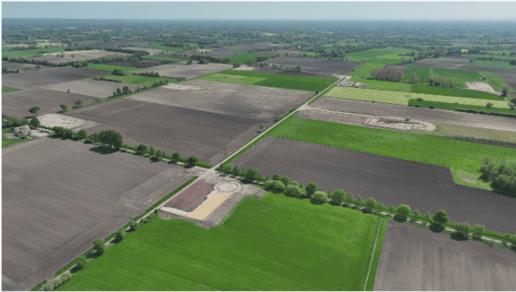
Luftansicht des noch entstehenden Bürgerwindparks Wagenfeld-Süd.
