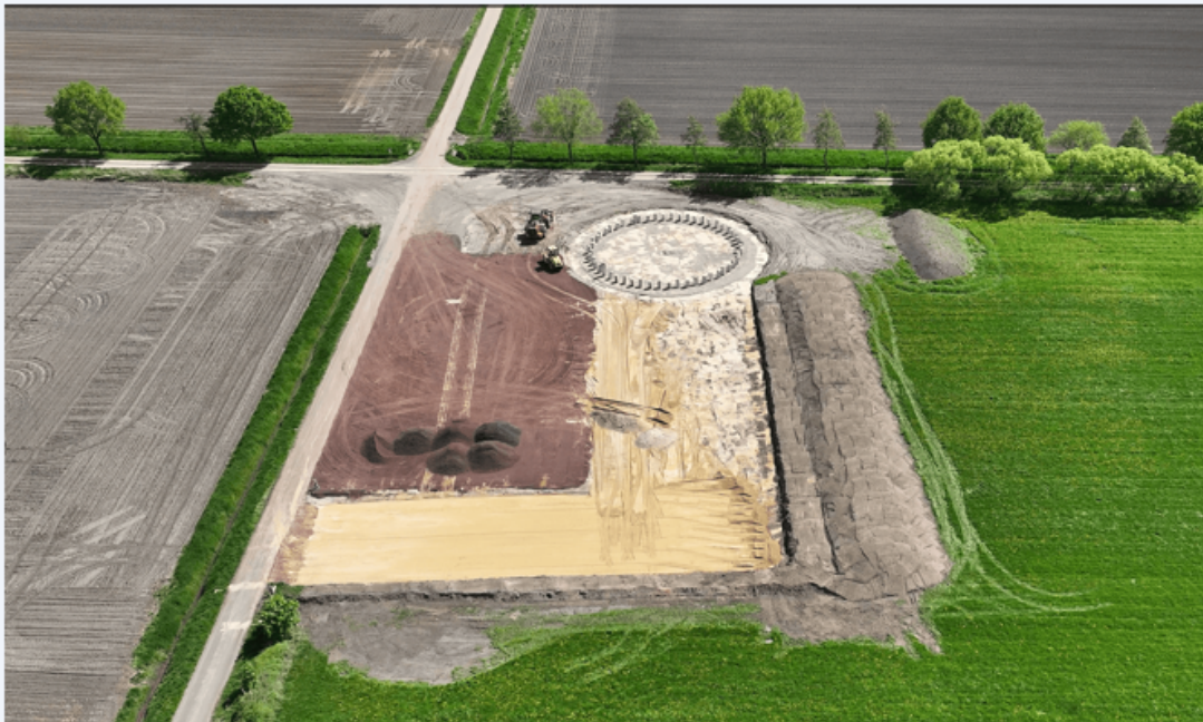
Luftbild einer der drei Windenergieanlagen.
